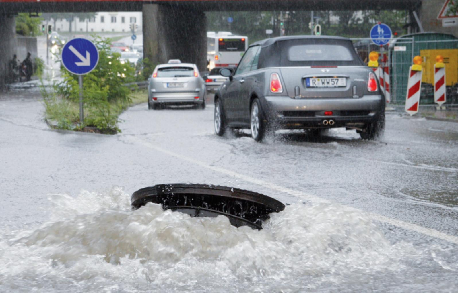
Überlastung der Kanalisation durch Starkregen
