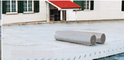
Die Dränbahn kann sofort belastet werden.
