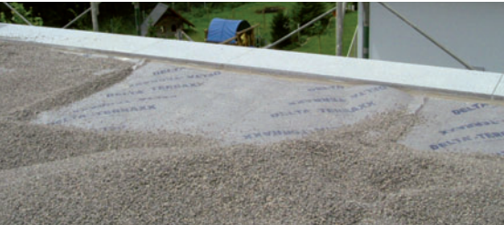
Dränierende Flächen benötigen ein Gefälle von 2–3%.
